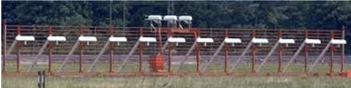
Landekursantennen am Bahnende erzeugen aufgefächertes Strahlungsdiagramm mit 90 Hz - und 150 Hz – AM  $m = 20\%$
